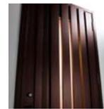
優れた遮熱効果により、強い日差しを浴びてもドア表面温度の上昇を抑制し、「熱反り」を軽減します。
